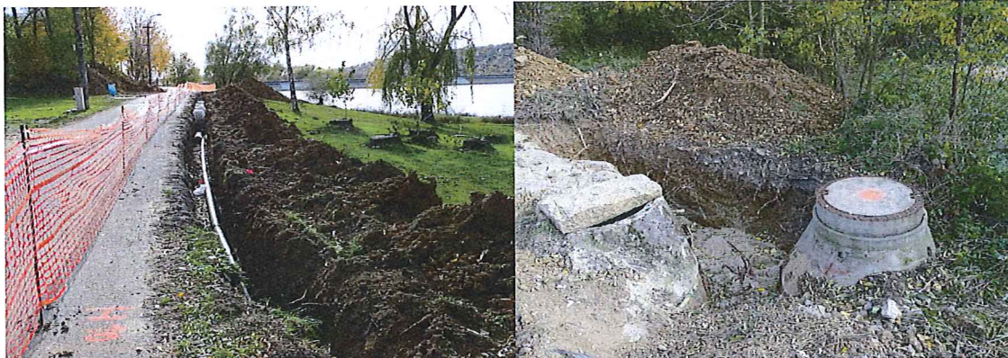
Stavebné práce na budovaní kanalizácie I. etapa 1. časť
