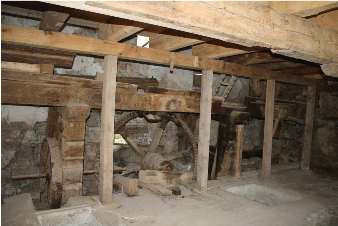
Obr.č.5. mlynská hranica pri návodnej stene objektu mlyna - stav pred reštaurovaním.
