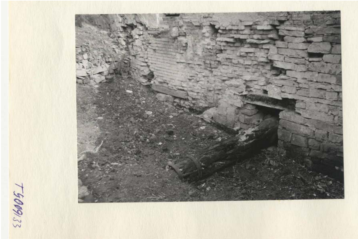
Obr.č.43. dobová fotografia - hriadeľ hlavného náhonu.
