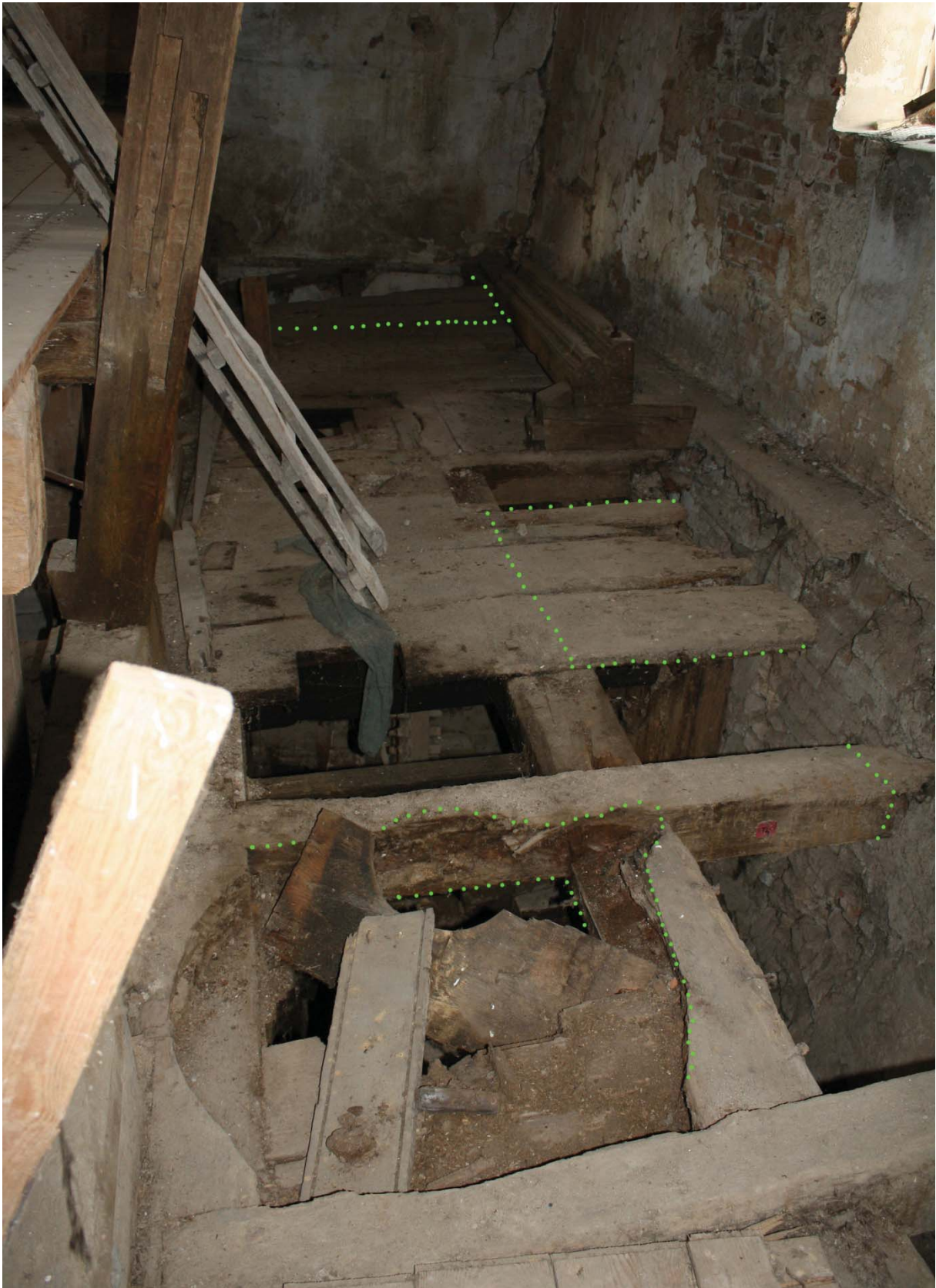
Obr.č.1. schematicke vyznačenie poškodených drevených prvkov podesty .
