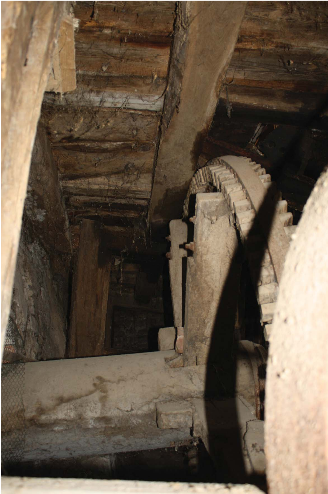
Obr.č.16. drevená nosná konštrukcia a dosky podesty - spodný pohľad.
