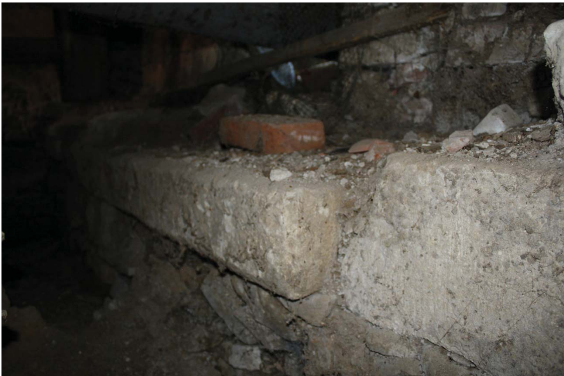
Obr.č.35. Základové kamene pod mlynskou hranicou
