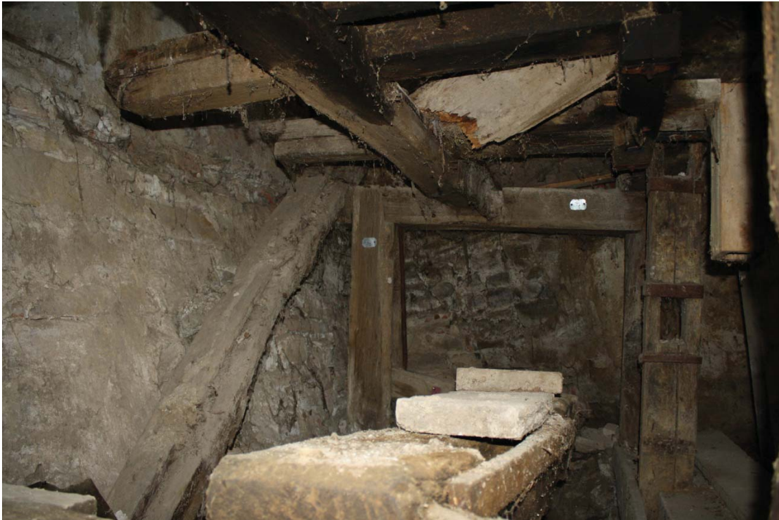
Obr.č.34. drevená nosná konštrukcia - spodný pohľad.
