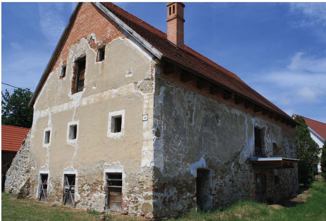
Obr.č 3.objekt mlyna stav počas obnovy.
