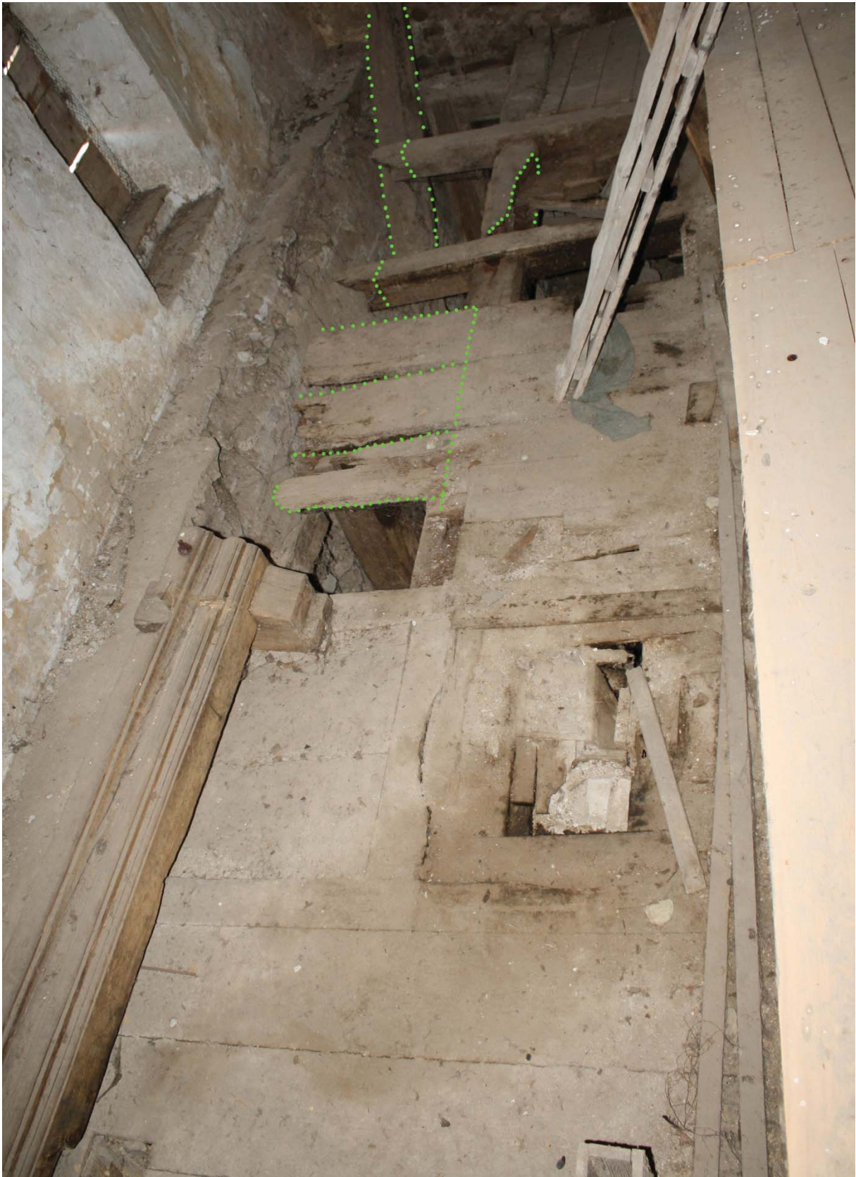
Obr.č.2. schematicke vyznačenie poškodených drevených prvkov podesty .
