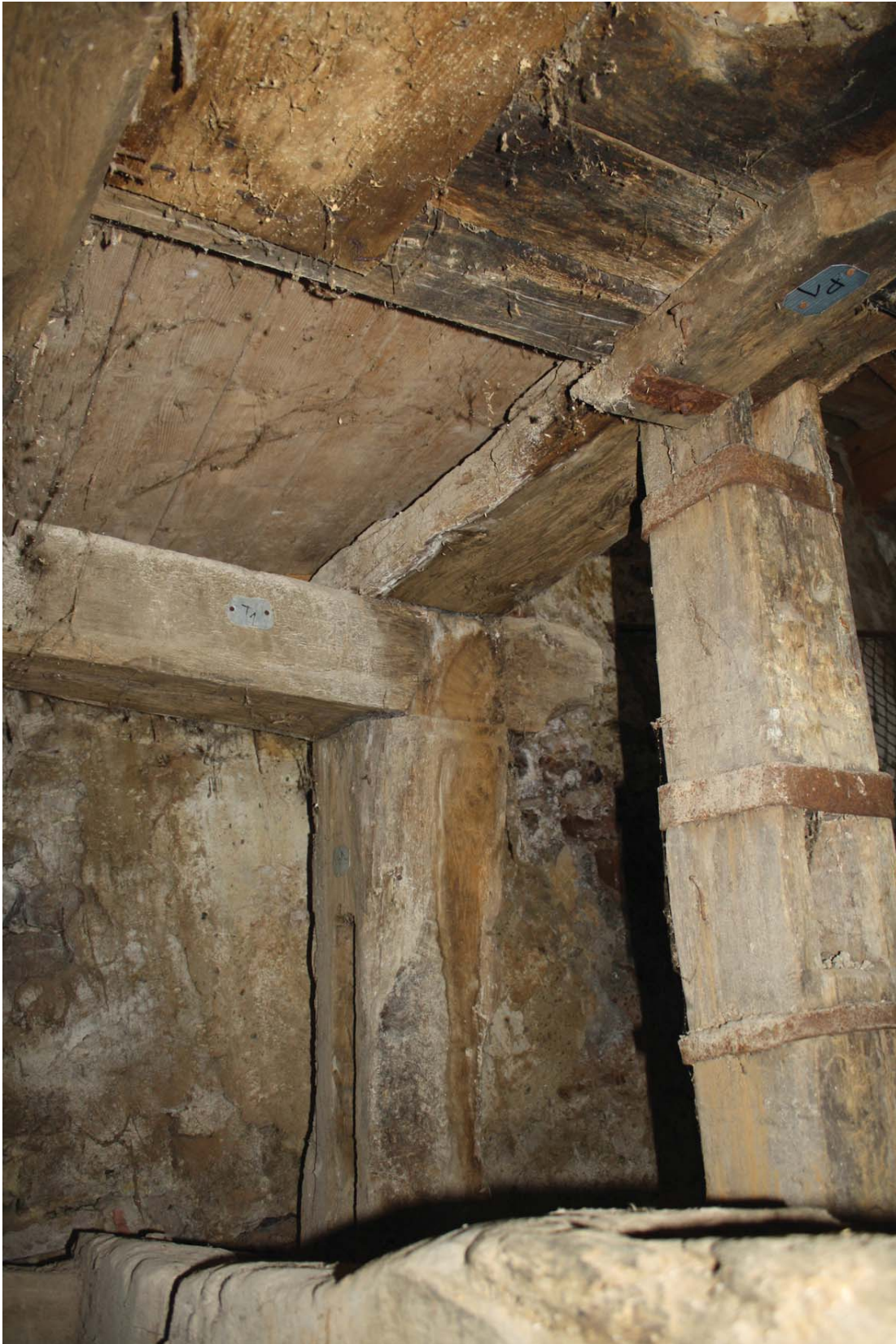
Obr.č.18. drevená nosná konštrukcia, svorové stĺpy - spodný pohľad.
